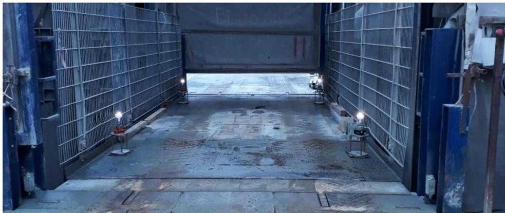
**Abb. 4:** Schachtkopf Fröschnitz mit 4 Lotkonsolen auf der Transportplattform (eigene Darstellung)
